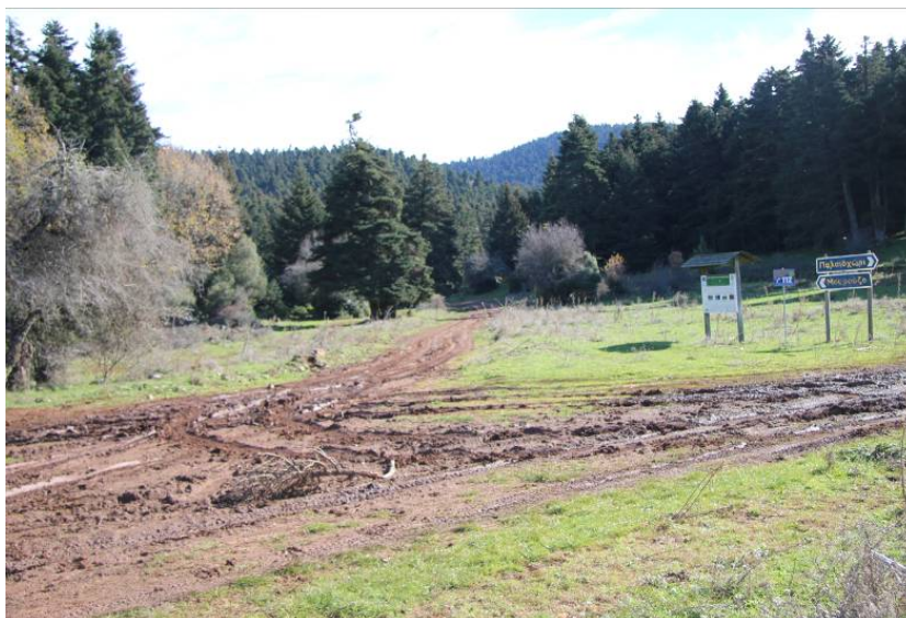
Εικόνα 4.2: Κατάσταση επιφάνειας καταστρώματος διασταύρωσης (Γ. Λυριντζής)
